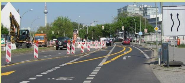
Foto: Radverkehrsführungen sind auch bei Baustellen sicherzustellen
