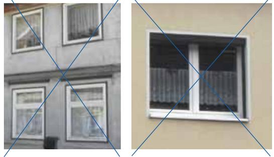
Das einzelne Fenster wird am stärksten geprägt durch seine Gliederung und Sprossung. Historische Fenster in der Altstadt sind kleinteilig gesprosst. Typisch ist die Ausführung mit einem zweiflügeligen Oberlicht und zwei unteren Fensterflügeln. Die einzelnen Flügel haben je nach Bauzeit und Größe horizontale glasteilende Sprossen.
