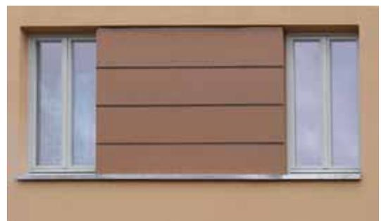
Bei Putzfassaden wurden die Sohlbänke der Fenster traditionell mit Zinkblech abgedeckt, das einen Rundwulst als Tropfkante hat. Der Rundwulst sichert eine schmale Ansichtsbreite.
