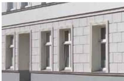
Der in den 1950–70er Jahren beliebte „Kratzputz“ oder anderer grobkörniger Putz passt nicht zu den Altstadtfassaden. Bei Umbauten sollte er ersetzt werden.
