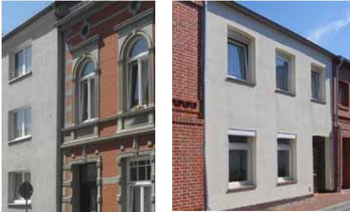
*Fassade links bzw. Mitte: Durch das Wärmedämmverbundsystem ging die Fassadengliederung verloren*
