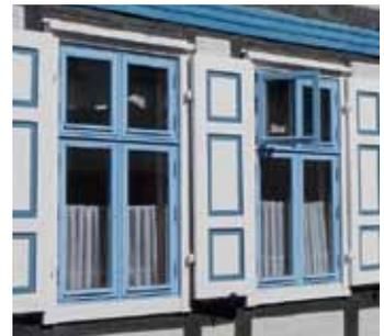
Schöne Fenster sind geprägt durch schlanke Rahmenquerschnitte. Für moderne Isolierverglasungen sind große Holzquerschnitte erforderlich. Um dennoch das Bild alter Fenster mit modernem Wärmeschutz zu verbinden, bieten sich Verbund- oder Kastenfenster an.
