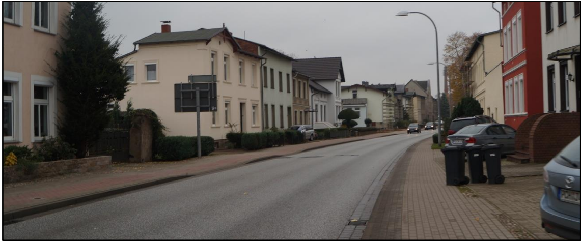
Abb. 9 Bestandssituation Schweriner Straße (B 321)
