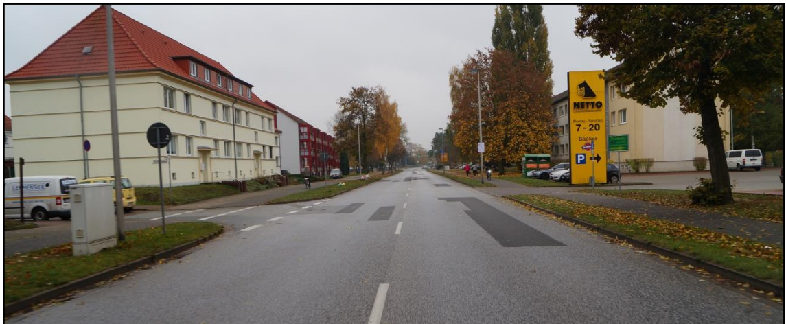
Abb. 2 Bestandssituation Westring (B 191)
