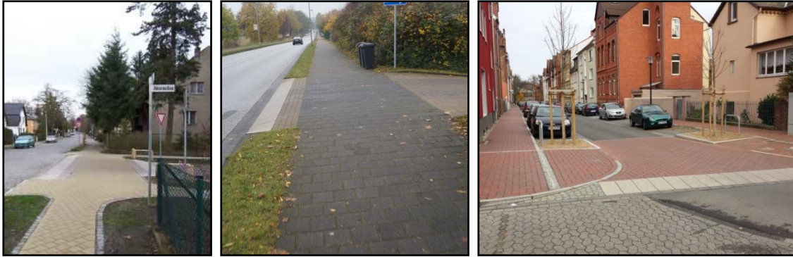
Abb. 19 Beispiele Gehwegüberfahrten bzw. -aufpflasterung (Erkner, Parchim, Hildesheim)
