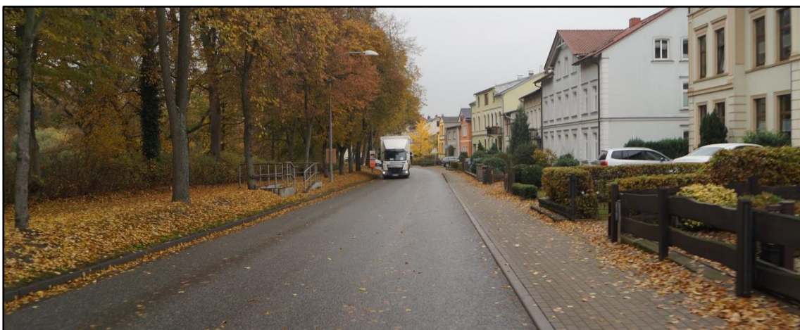
Abb. 8 Bestandssituation Wallallee (B 321)
