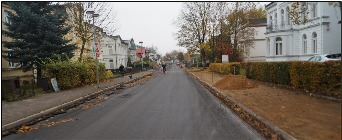
Abb. 6 Bestandssituation Putlitzer Straße (B 191 / B 321)
