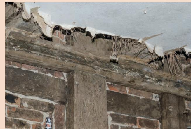
Der geschnitzte Balken ist gleichzeitig Teil der Fachwerkkonstruktion (er trägt die Deckenbalken) sowie der Dekoration des südöstlichen Erdgeschossraums. Hier befand sich vermutlich ein repräsentatives Kontor. 2019
