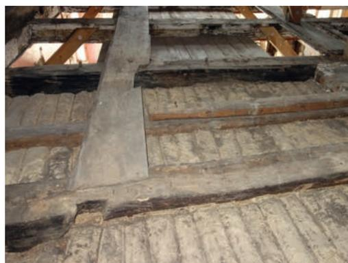
Freigelegte Holzbalkendecke mit Lehmwickelfüllungen ohne Bohlenbelag zum Dachraum, 2018
