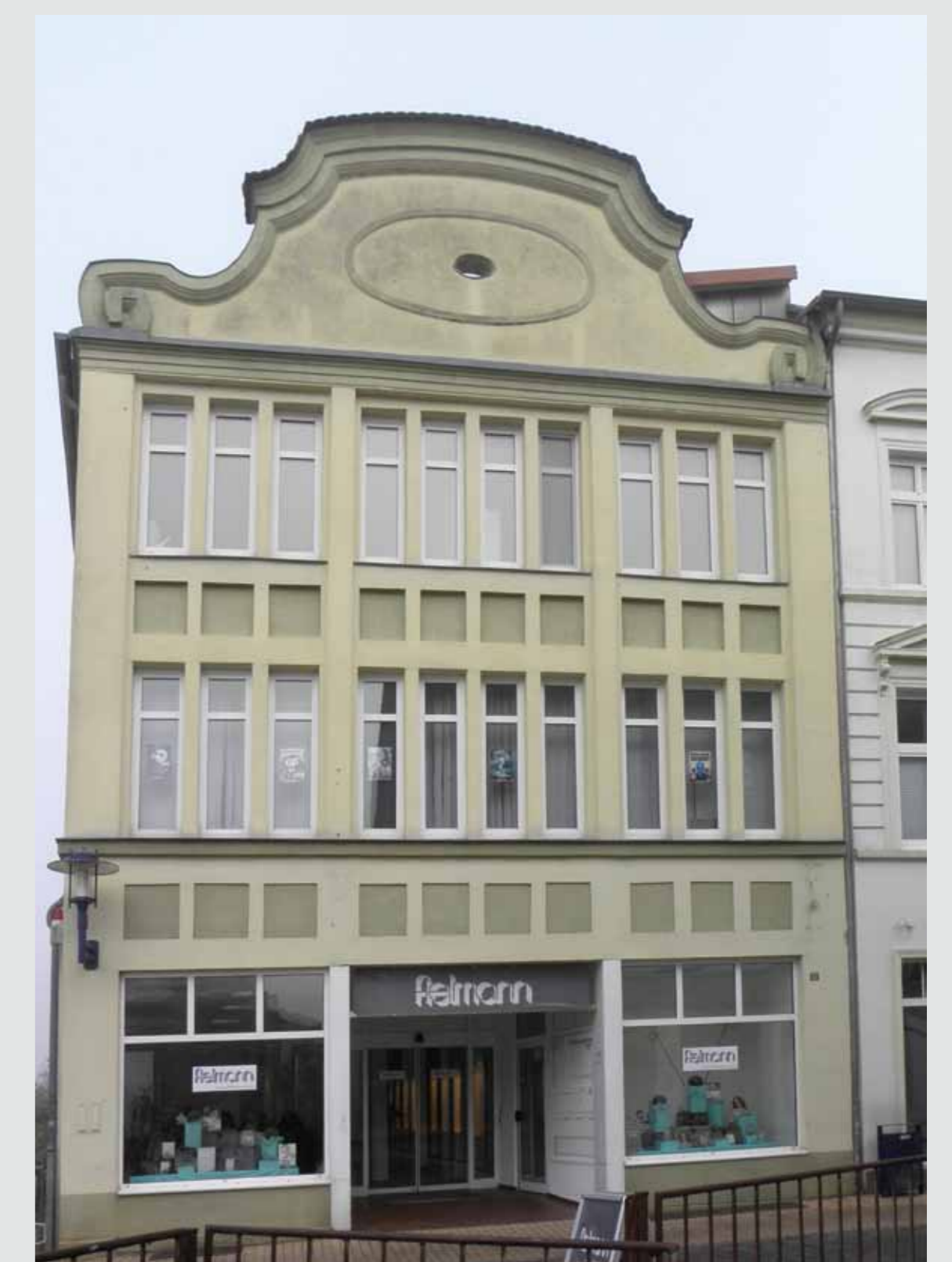
Leerstehendes Kaufhaus Lange Straße 37
