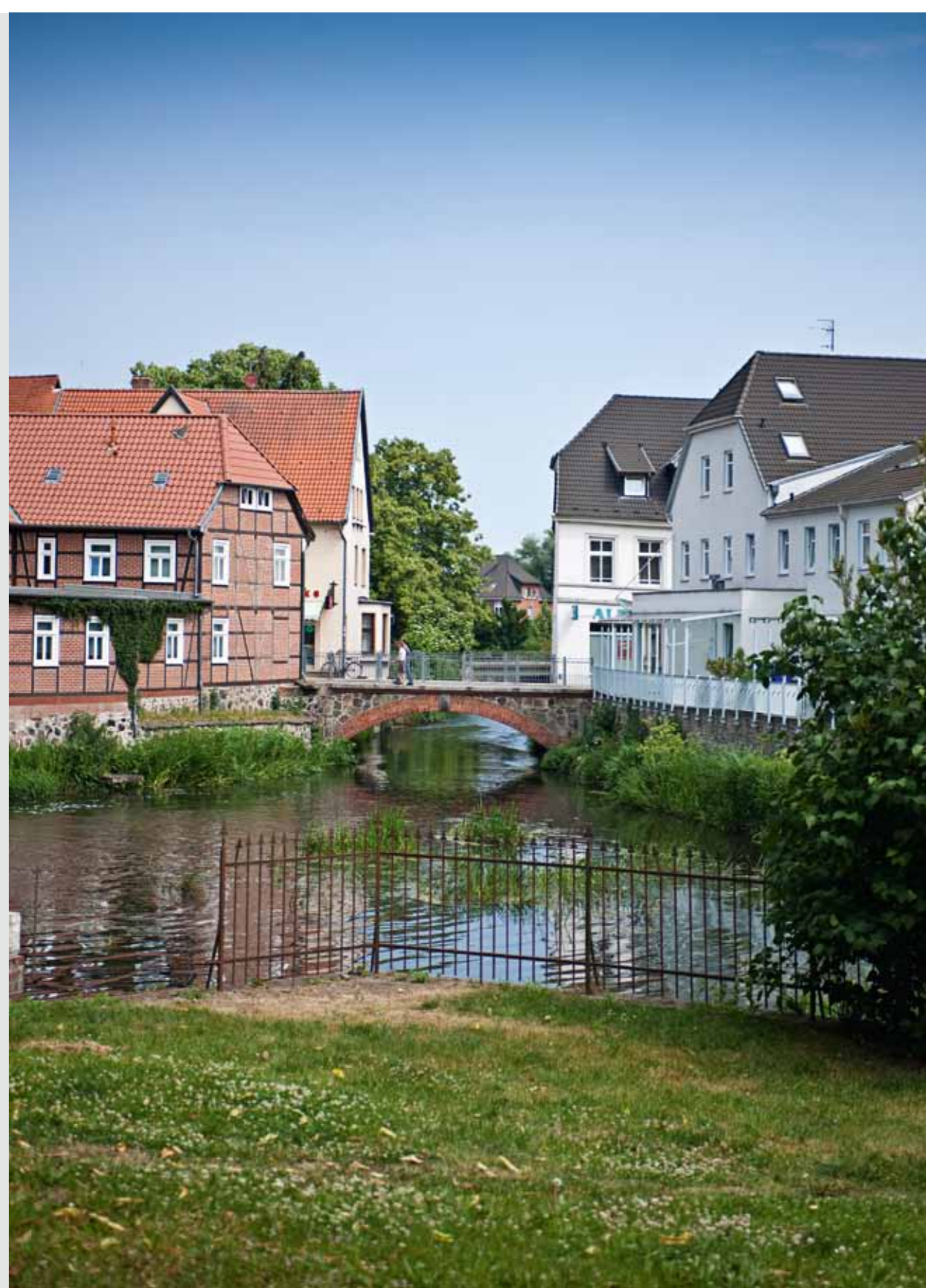
Eide mit Brücke an der Langen Straße, 2015 (Foto: J. Lehmann)
