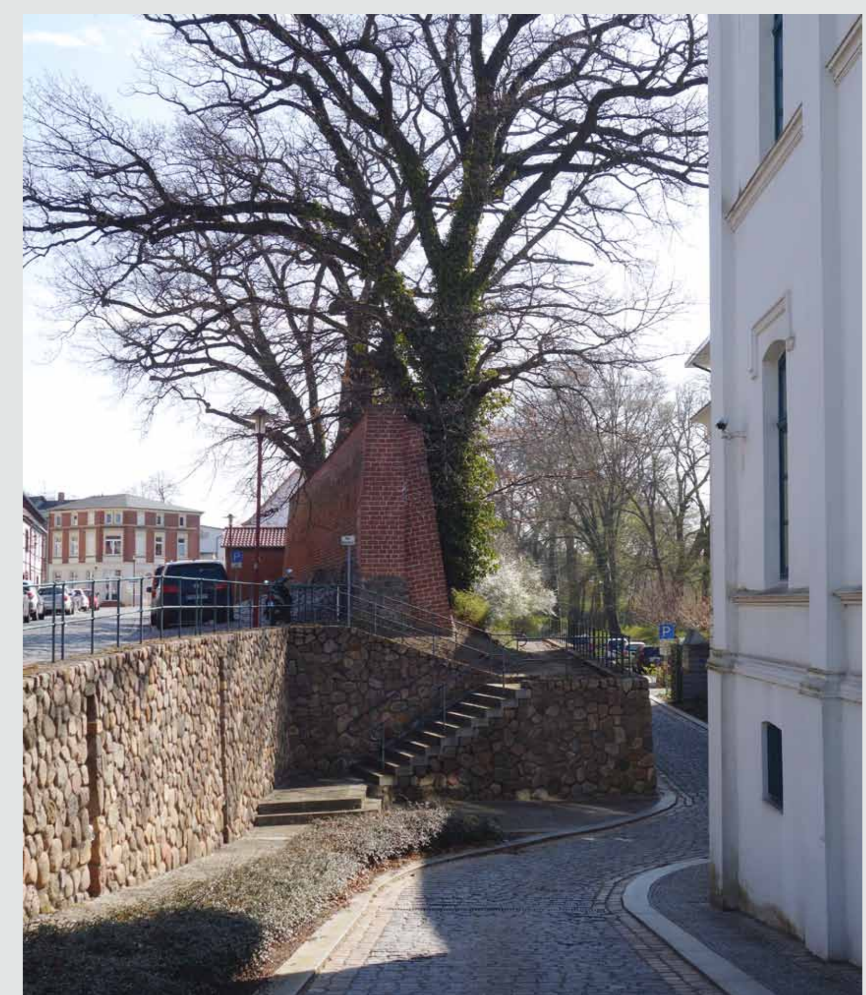
Sanierte Stadtmauerteile Am Wallhotel, 2015
