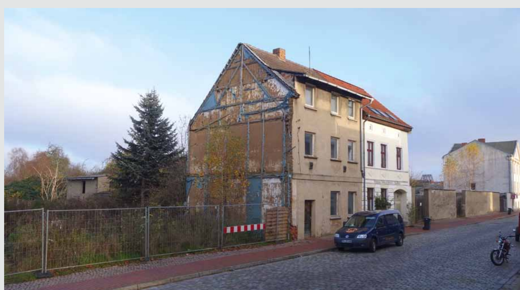
Problematische Baulücken Auf dem Brook
