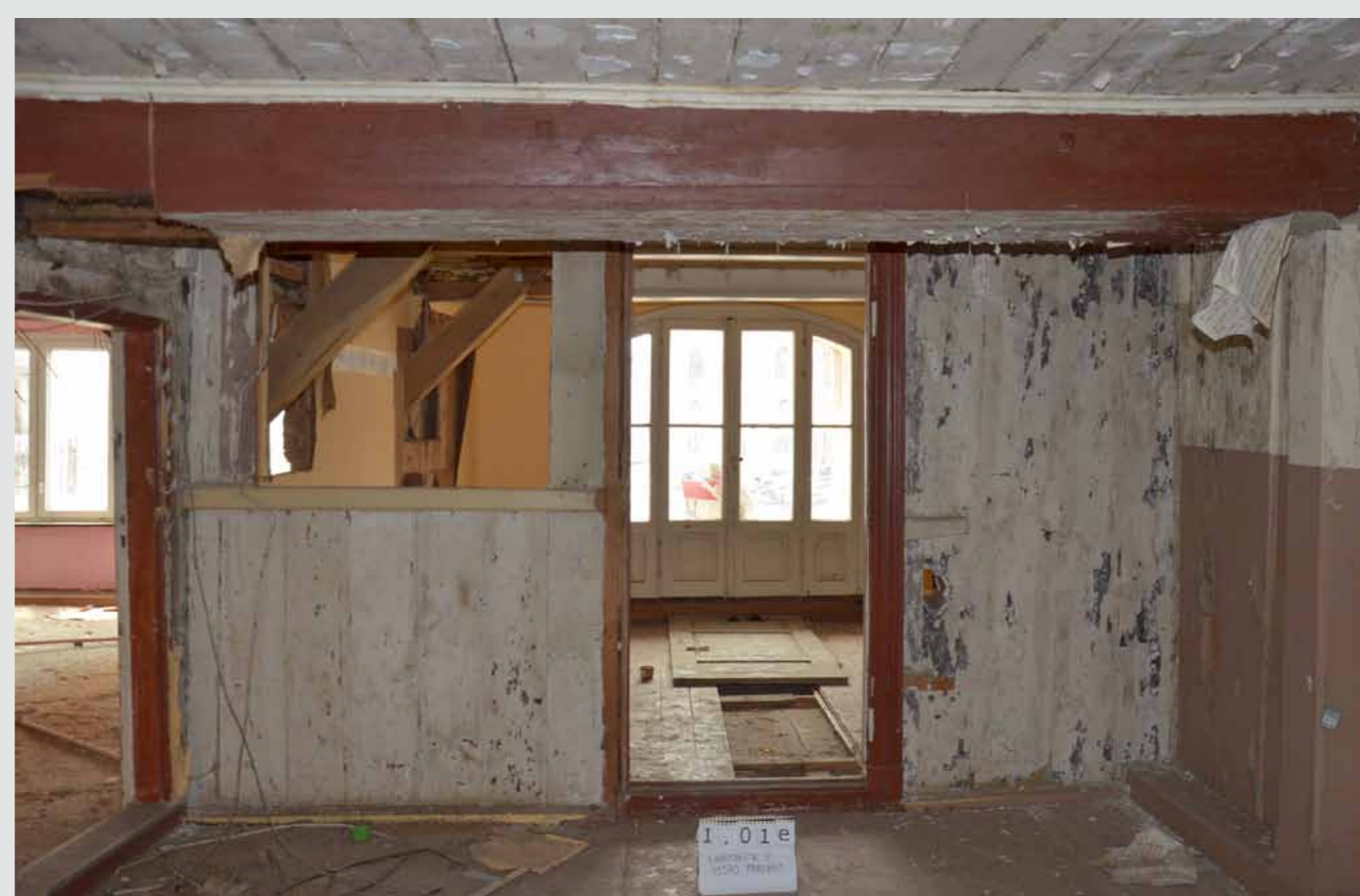
Obergeschoss vom Giebelhaus, 2015
