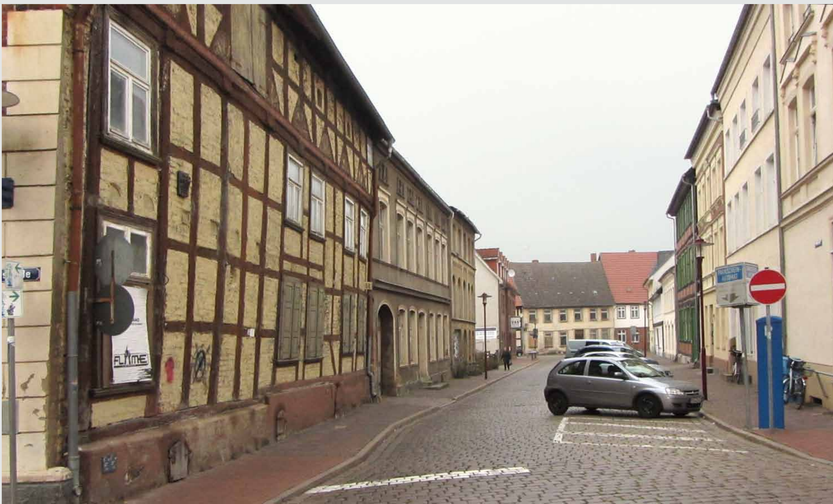
Blick vom Alten Markt in den Marstall, 2015, vor der Sanierung
