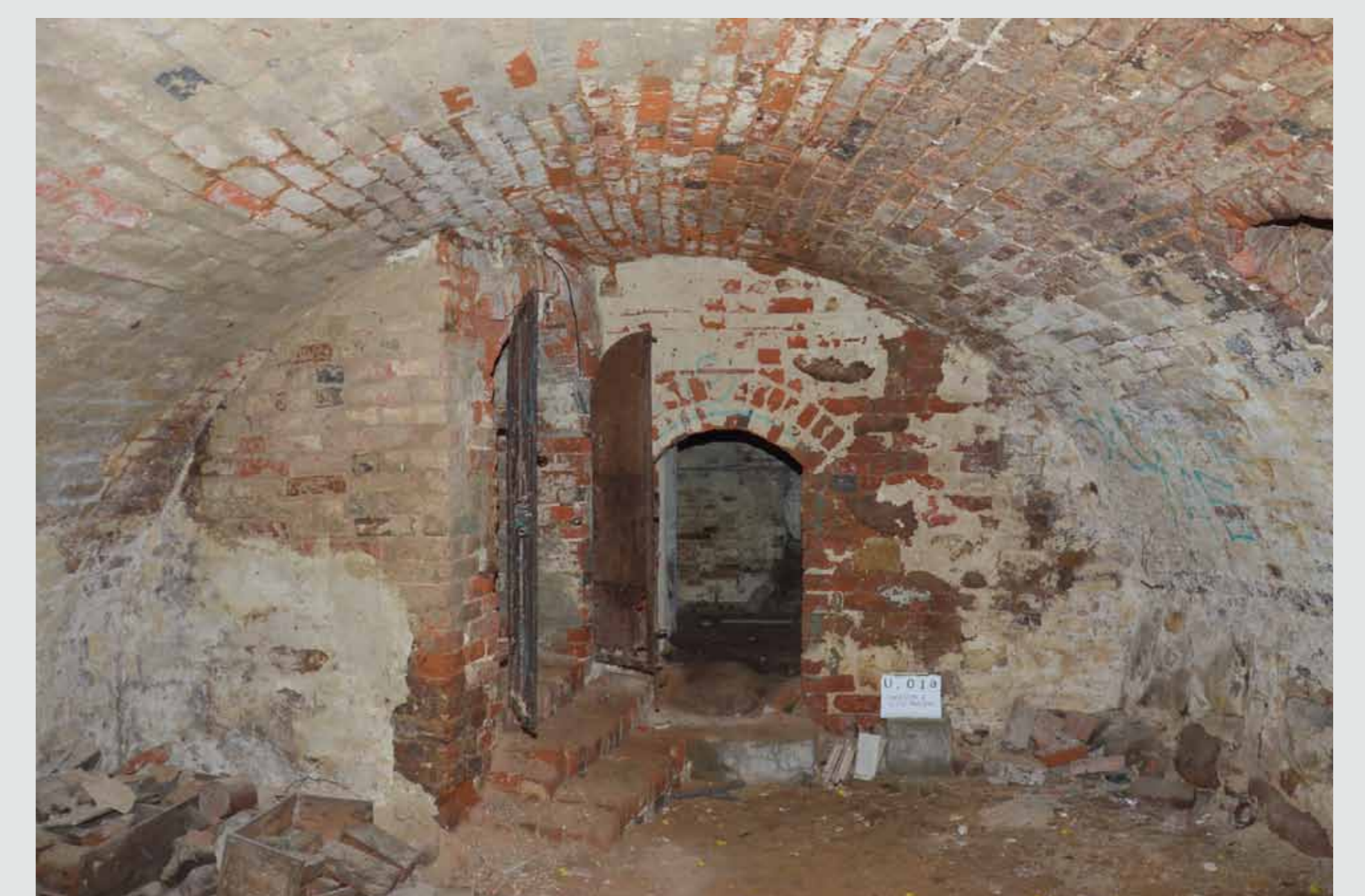
Großes Kellergewölbe im Giebelhaus, 2015
