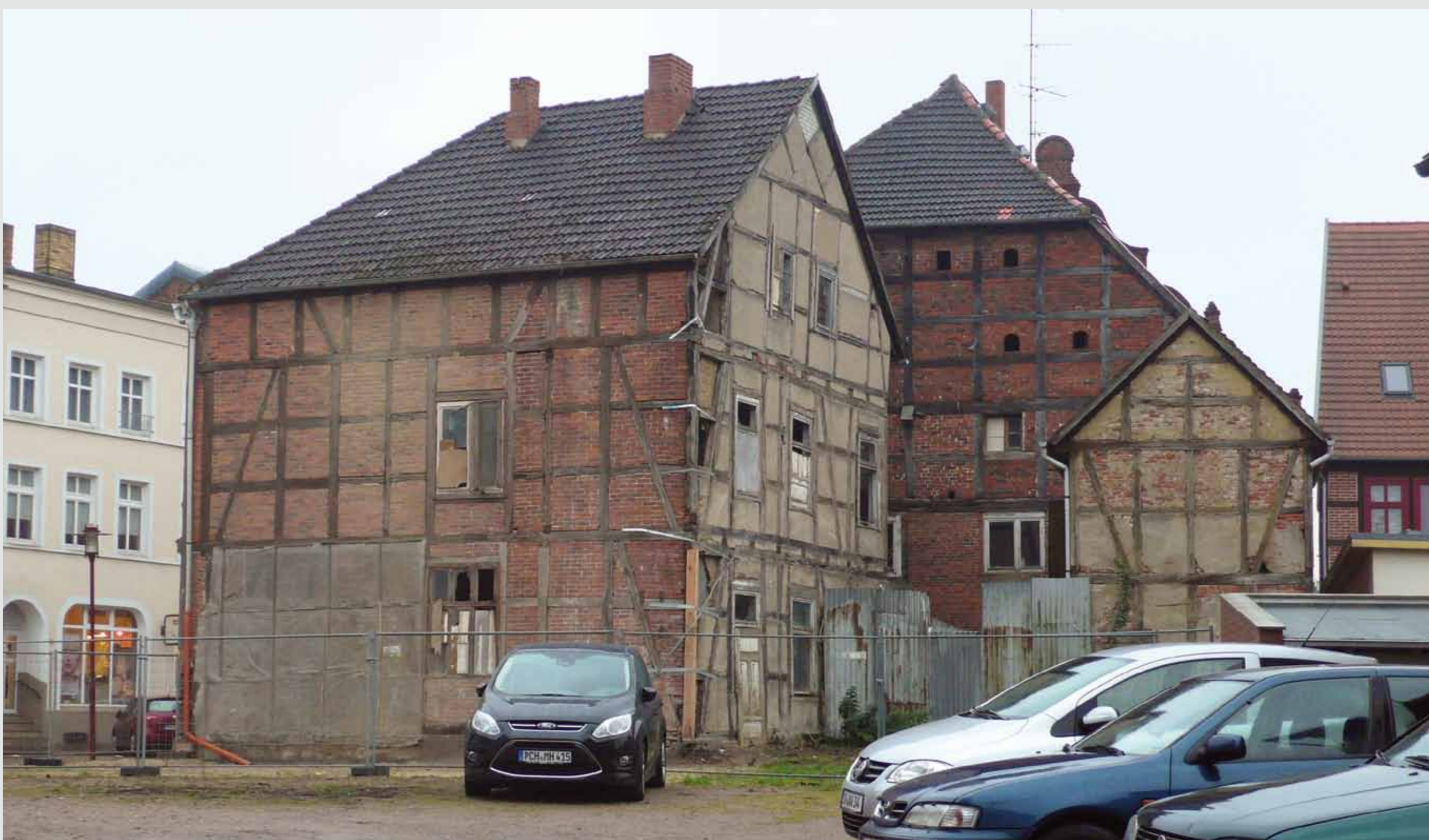
Anschlusswand zum geplanten Neubau und Hofseite Marstall 1 nach Abbruch Marstall 2, 2016
