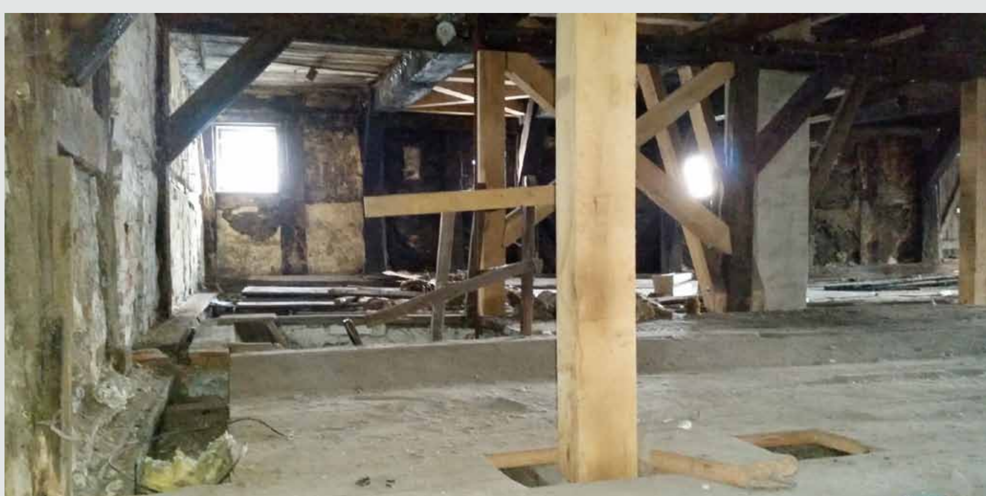
Blick in den Dachstuhlbereich vom Giebelhaus, 2015
