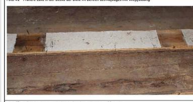
Foto 41 Frühere Luke in der Decke der Diele im Bereich des Aufzuges mit Weißfassung
