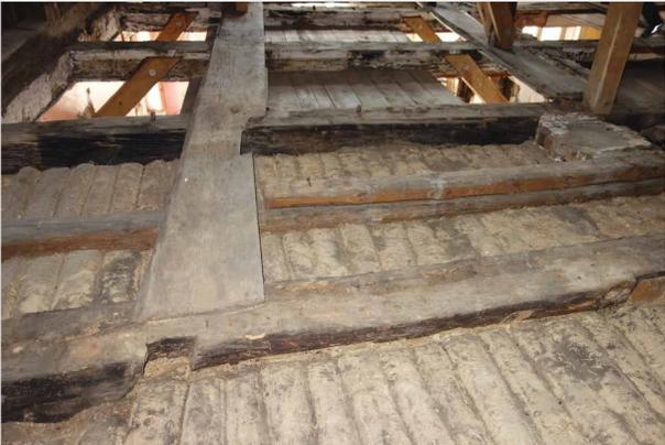
Freigelegte Holzbalkendecke mit Lehmwickelfüllung und Bohlenbelag zum Dachraum, Giebelhaus, 2018
