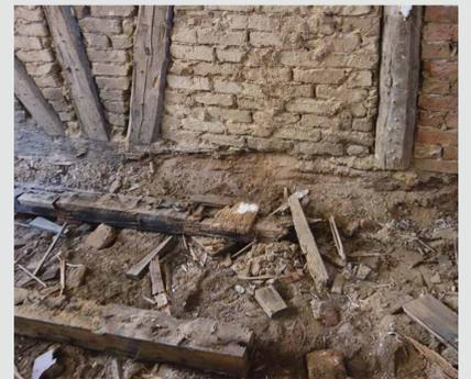
Geschädigte Balken- und Schwellenhölzer im Fundamentbereich, Marstall 1, 2018
