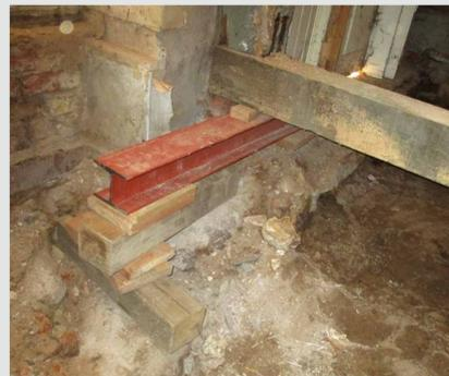
Zwischenzeitliche Unterfangung von Schwellen für Fundamentarbeiten, Giebelhaus, 2019
