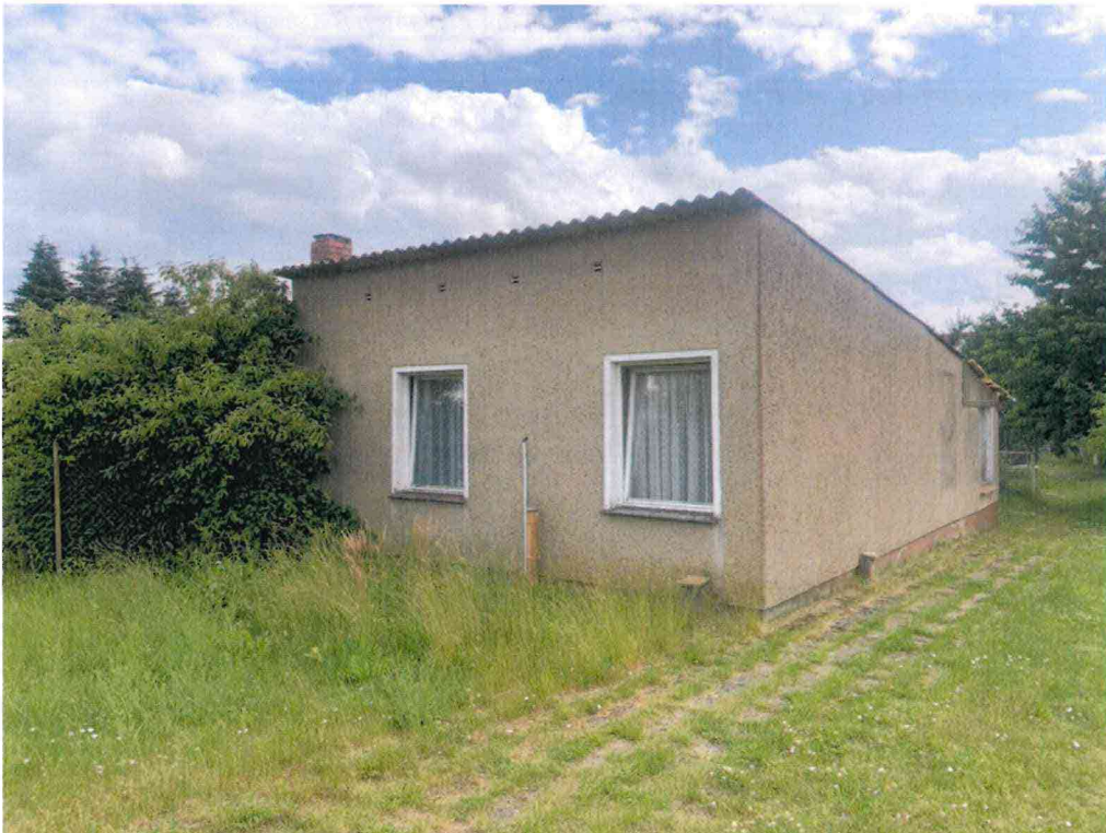
Abb. 4: Flurstück 110: Gartenhaus, Betonplattenweg und Rasen
