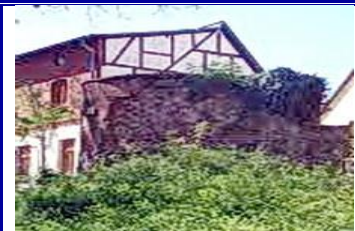
Wickturm der Stadtmauer -Wallanlagen Parchim-
